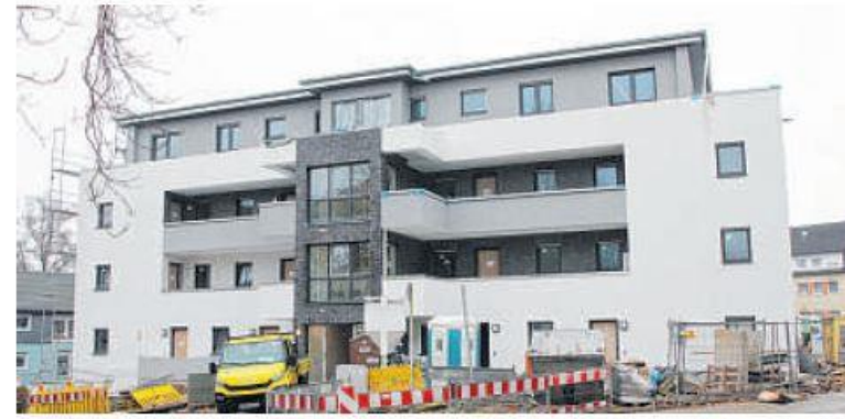
Das Gebäude am Breslauer Platz steht kurz vor der Fertigstellung. Im Januar sollen dort die ersten WG-Bewohner einziehen.
